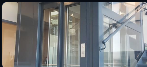
Pose et travaux — respect des règles de sécurité et du planning.
